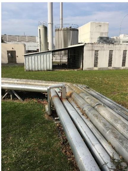
*Figure 4-5 : Rack tuyauterie (eau, vapeur et électricité)*
